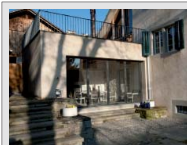
NÜTZLICHER ANBAU: Wo früher eine verlotterte Werkstatt stand, gibt es heute einen gemütlichen Wintergarten mit Cheminée und eine neue Terrasse mit Seesicht.
