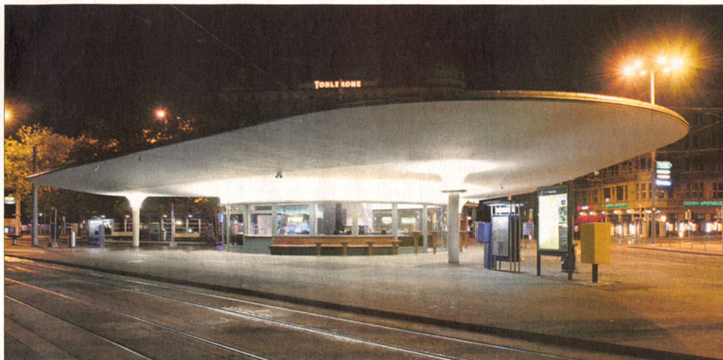
Das Prachtdach des Bellevue-Rondells nach den Plänen des Architekten Hermann Herter aus dem Jahre 1938 nach der Renovation. (Bild Franco Bottini)
